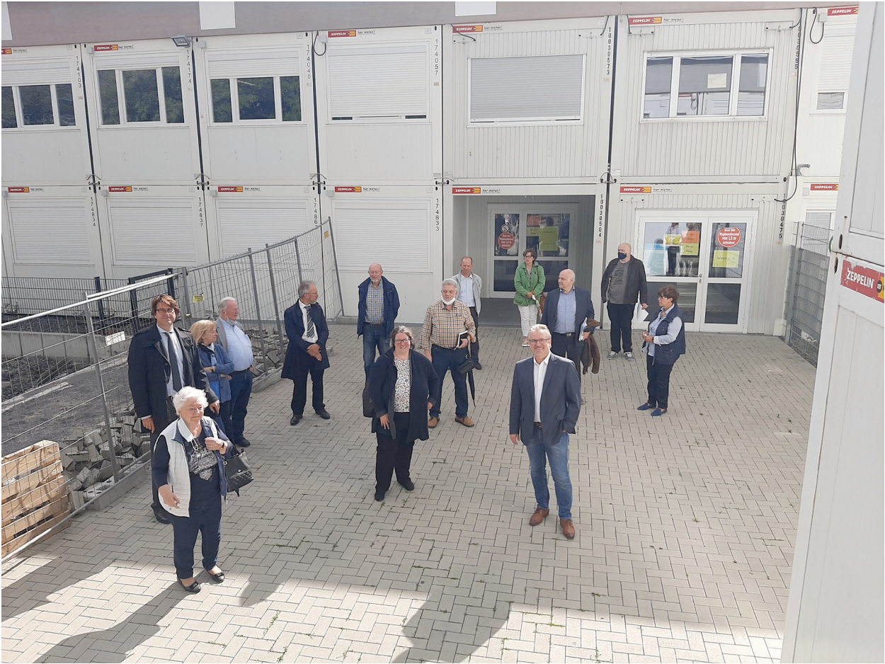
(Foto: CDU-Fraktion „vor Ort“ mit dem OB-Kandidaten Marc Buchholz: Auf der Großbaustelle am Schulzentrum Saarn, vor dem Container-Interimsstandort)
